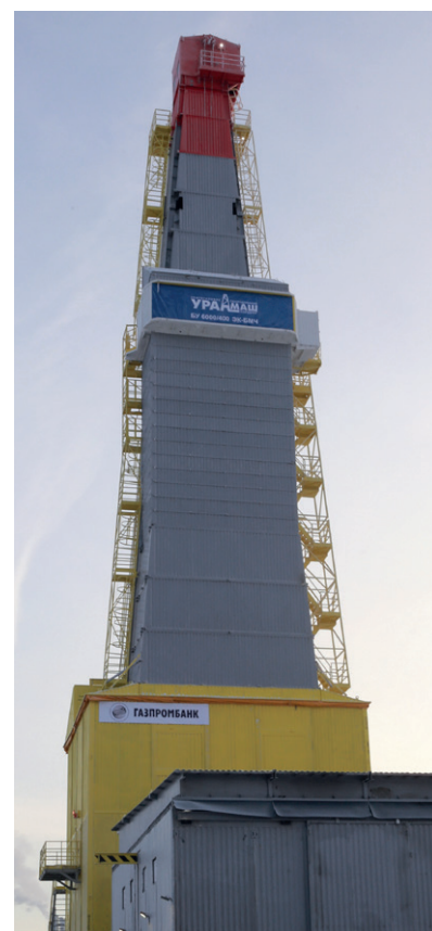
Уникальная буровая установка полностью закрытого типа позволит нефтяникам работать в любых метеоусловиях
